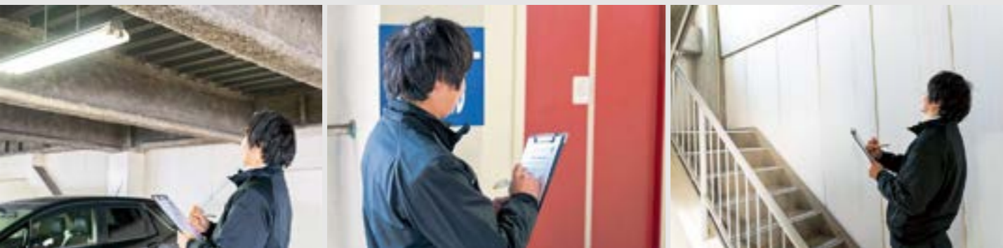
蛍光灯やエレベーターホール、階段をチェックする谷口さん。蛍光灯をLEDに変更するだけで、経費削減と同時に駐車場の明るさが向上し、利用者に安心感のある空間を提供できる。
